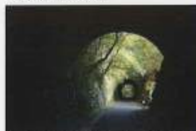
18-②1号2号厚ヶ瀬トンネル(自転車道)
